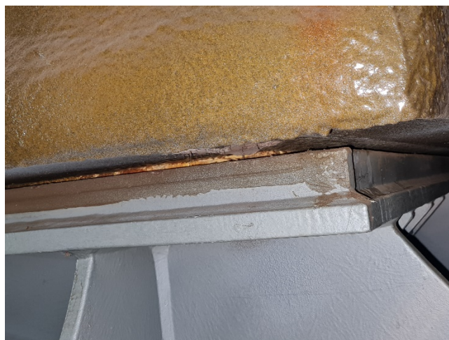
Slika 9. Spremnik tereta oslanja se na brodsku konstrukciju; Izvor: arhiva autora
