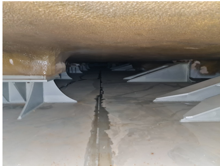
Slika 10. Prostor između spremnika tereta i balastnih spremnika (engl. cargo hold space ); Izvor: arhiva autora
