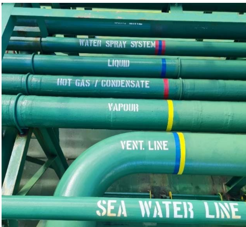
Slika 5. Oznake cjevovoda na LPG brodu; Izvor: arhiva autora
