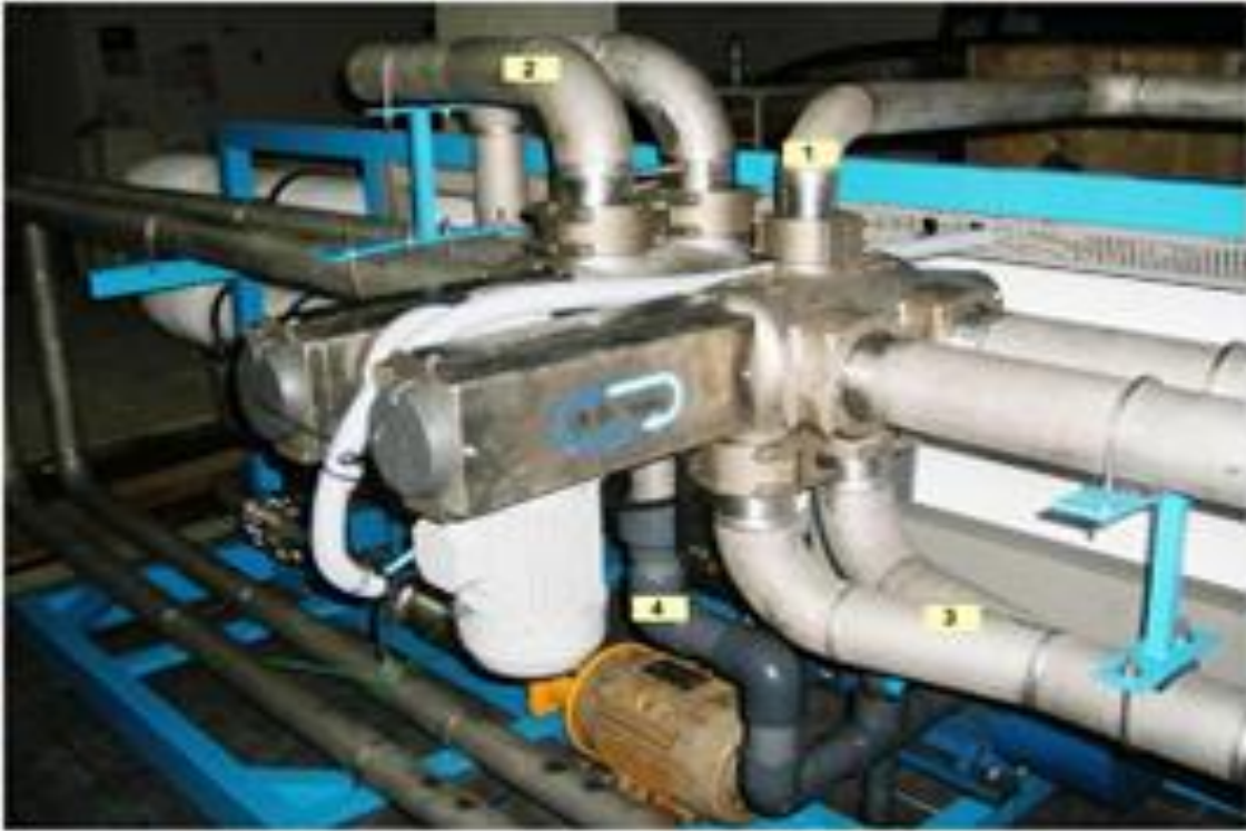
Slika 18: Pogled na RO Kinetic® tijelo ventila. Unutarnji protoci su: 1. ulaz slane vode u HP, 2. izlaz morske vode u HP, 3. izlaz morske vode u LP, 4. izlaz slane vode u LP. (HP: visoko-tlačni, LP: nisko-tlačni) Izvor: M. Barreto.[6]
