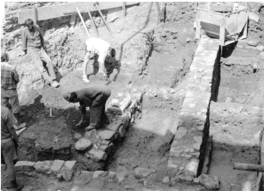
Slika 4.: Arhivska iskopavanja na lokaciji Bolnička 1 u lipnju 1993. Temelji lučkih zgrada nalaze se cca metar ispod razine susjednoga trga (Tartinijev trg).
