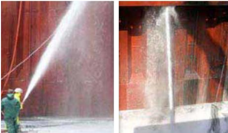
Slika 26. Pranje gornjih dijelova skladišta
