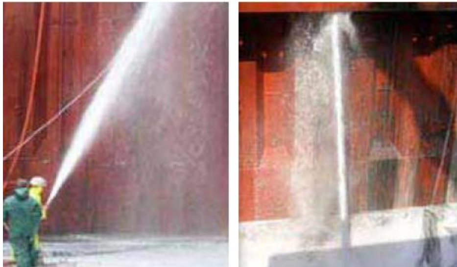
Slika 26. Pranje gornjih dijelova skladišta
