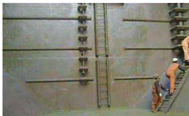
Slika 51. Čišćenje skladišta zahtjeva posadu
