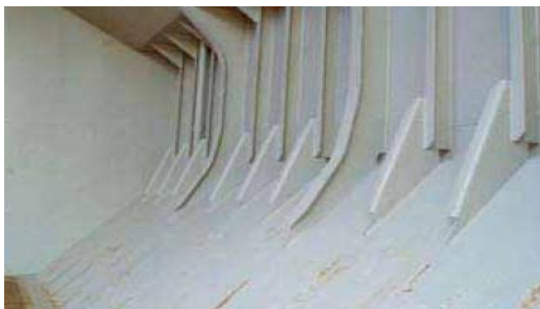
Slika 24. Skladište broda za prijevoz rasutih tereta koje je spremno za ukrcaj žitarica
