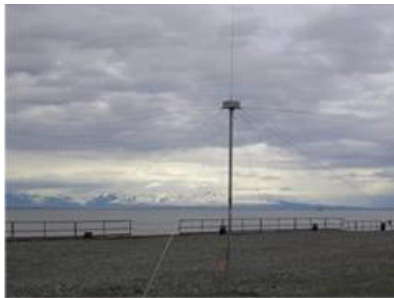
Slika 11. Primjer visoko frekventne antene; Izvor:
