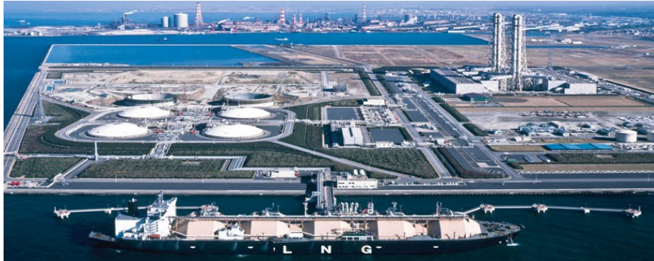
Slika 2. Postrojenje za obradu prirodnog plina [16]
