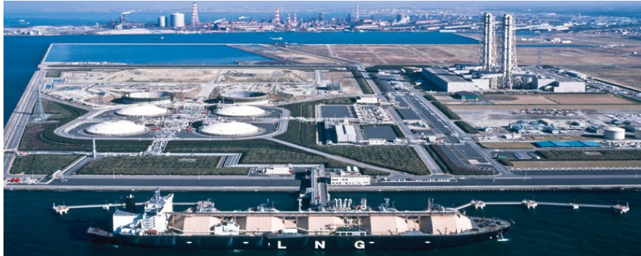
Slika 2. Postrojenje za obradu prirodnog plina [16]
