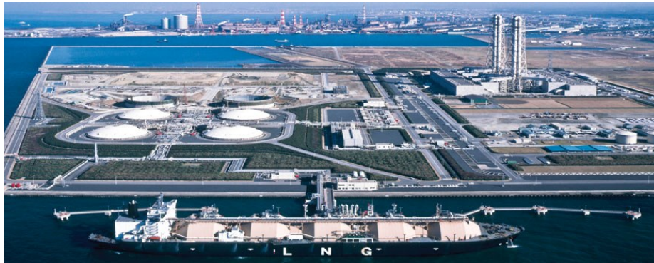
Slika 2. Postrojenje za obradu prirodnog plina [16]
